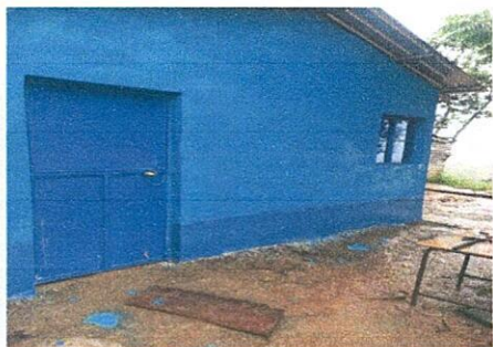
Foto 3: Finalizado de construcción de la dirección
