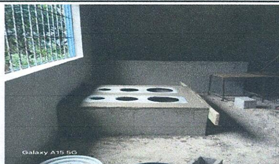
Foto 6: Instalación de polleton, pila y mesa de torta culminado
